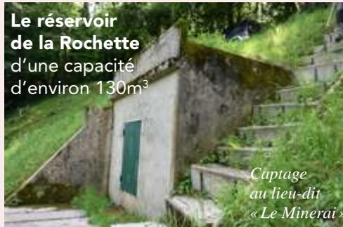
**Le réservoir de La Rochette** est alimenté gravitairement par le captage de 2 sources situées à quelques centaines de mètres et environ 10 et 20m plus haut en altitude au lieu-dit « Le minerai ».
